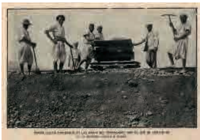
Construcció línia ferrocarril miner Melilla 1909
